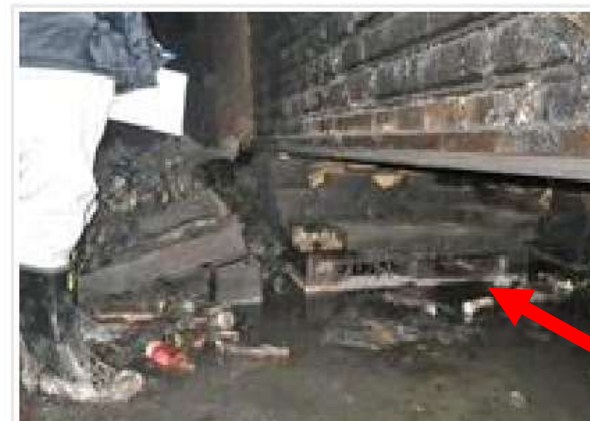
障害物で閉まりきらず火の回りを防げなかった防火シャッター = 1日、埼玉県三芳町（国交省提供）
